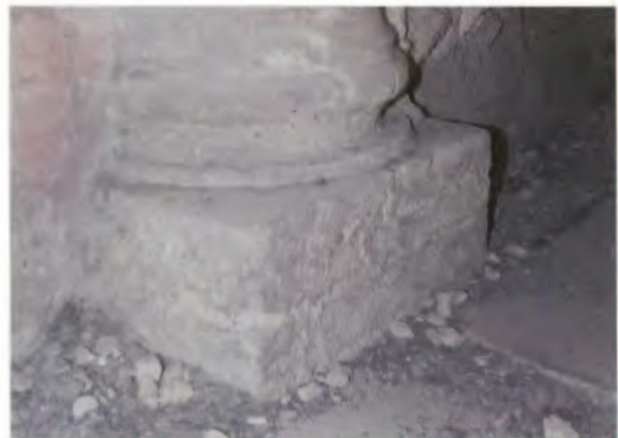
Base attica con il toro inferiore e il piinto unghiato non ancora terminati.
